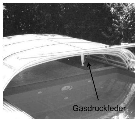
Bild 3: Klappe mit Gasdruckfeder
