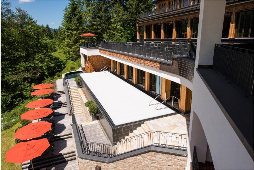
„ZU“ Ruhebetrieb – Schwimmbadabdeckung ist geschlossen
